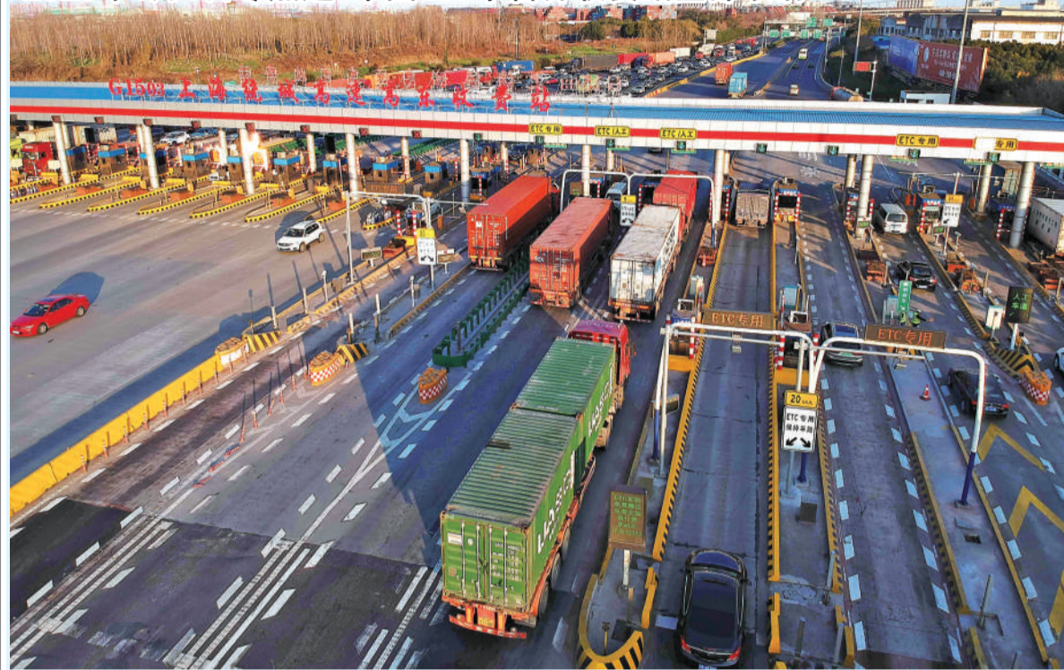
2020年1月1日零点起,中国29个联网省份的487个省界收费站全部取消。交通运输部公路局局长吴德金表示,取消高速公路省界收费站不是取消收费,是在拆除省界实体收费站的同时,通过技术手段实现车辆跨省行驶时不停车快速交费。
