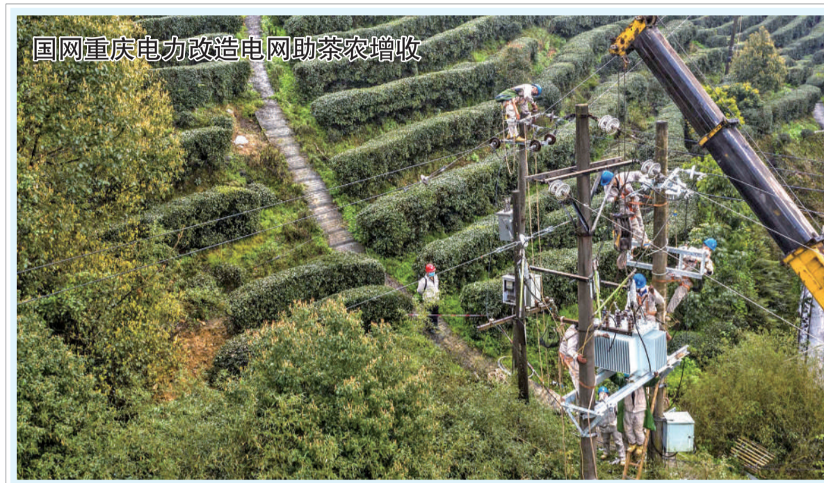
国网重庆电力改造电网助农增收 3月6日,记者从国网重庆市电力公司获悉,国网重庆江津电力公司帮助茶农实现“以电代煤”绿色高效制茶,在其支持下,重庆热岭茶业有限公司拥有的600余亩茶园年产量可达7万余斤。图为电力工人安装变压器配套设施,为茶园增容电量。 中新社发 钟欣 摄
