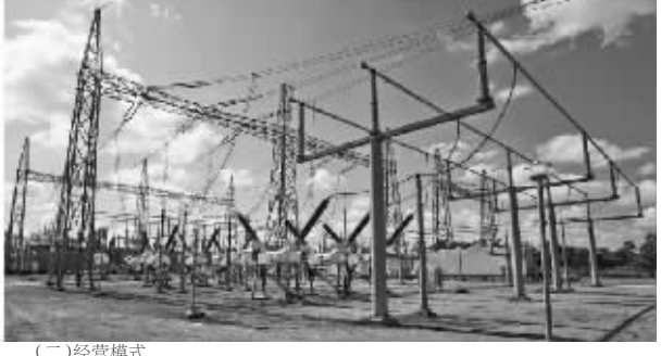
3.变电站构架:变电站是电力系统中变换电压、接受和分配电能、控制电力的流向和调整电压的电力设施,它通过其变压器将各级电压的电网联系起来,在电力系统中,变电站是输电和配电的集结点。
