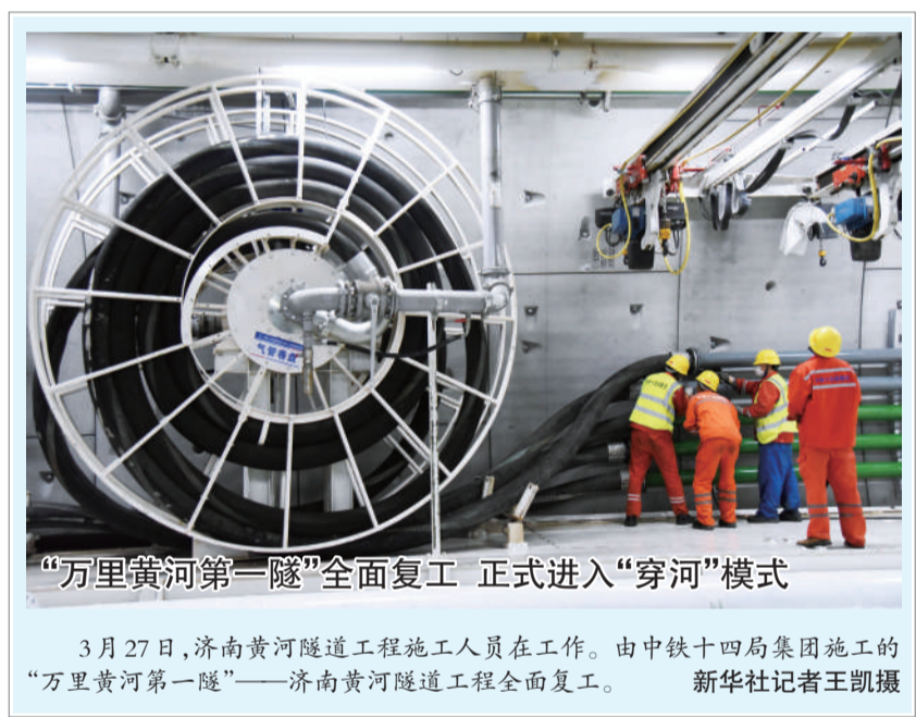
“万里黄河第一隧”全面复工 正式进入“穿河”模式 3月27日,济南黄河隧道工程施工人员在施工现场。由中铁十四局集团施工的“万里黄河第一隧”——济南黄河隧道工程全面复工。 新华社记者王凯摄
