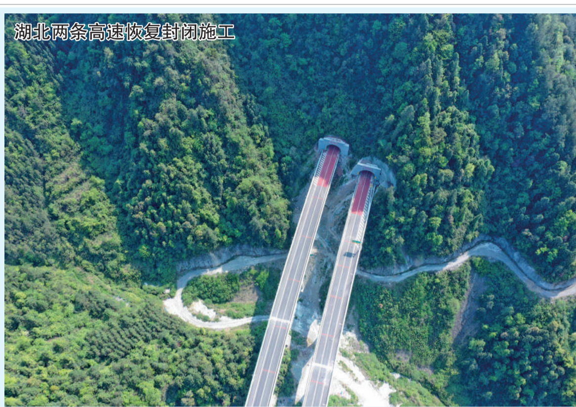
近日，修建于湖北省西部山区的宣鹤、建恩两条高速公路经过试运营后，恢复封闭施工，进一步完善相关设施，预计2020年6月正式通车。这是4月16日拍摄的宣鹤高速公路(无人机照片)。 新华社发(宋文 摄)
