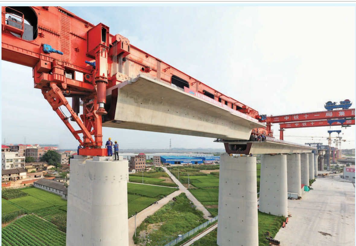
我国首台 1000 吨级高铁箱梁运架一体机投入使用
