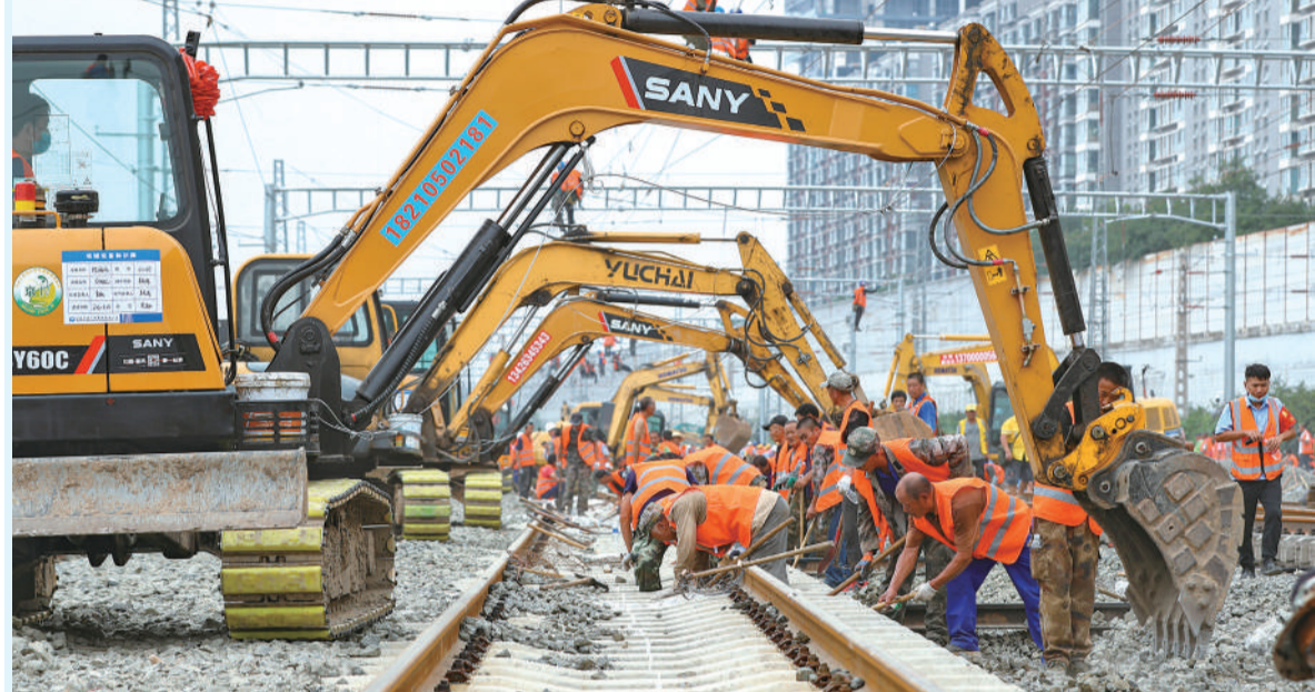
8月30日,北京丰台站改建工程开始京沪、京广线普速铁路拨线施工。当日拨接的京沪、京广普速铁路线原来位于新建丰台站北侧,拨接后,线路将从南侧站房内穿过。图为施工人员和大型机械协同作业。
