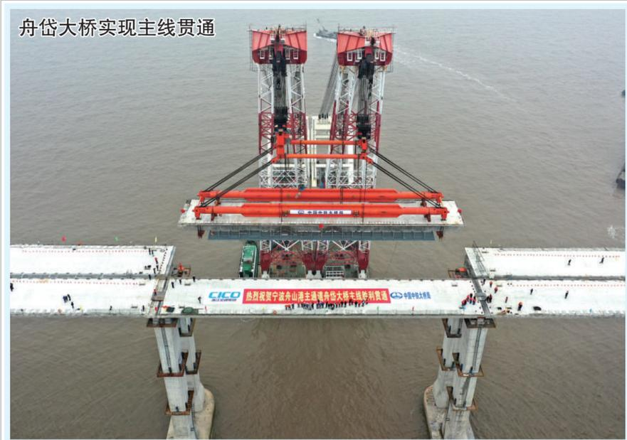
舟岱大桥实现主线贯通。2021年1月24日,浙江舟山,一片重达1800多吨的70米箱梁被海上大型浮吊缓缓放在舟岱大桥主通航孔北边跨处的高墩上,标志着浙江交通集团宁波舟山港主通道项目舟岱大桥顺利实现主线贯通。图片来源:人民视觉
