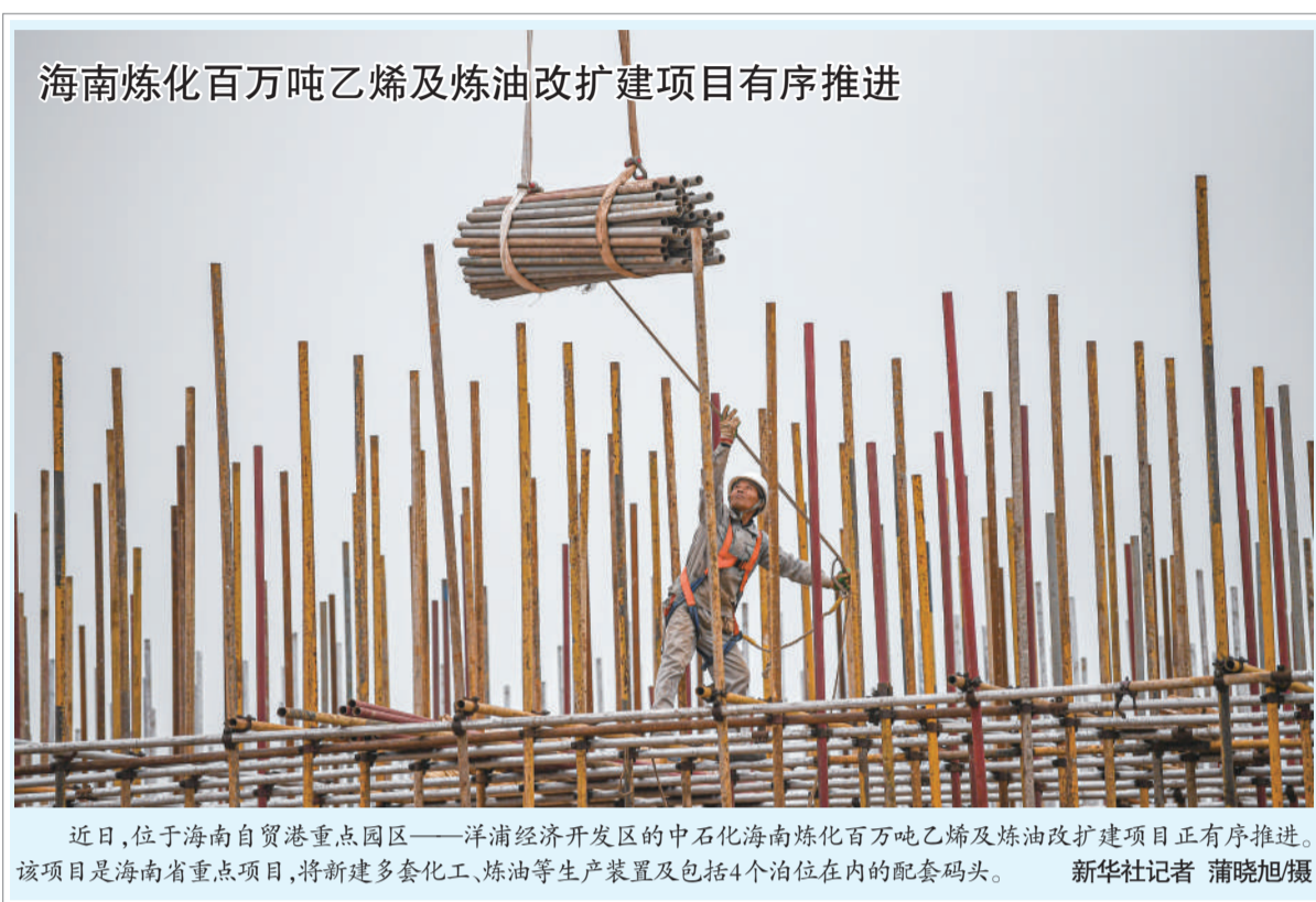
近日,位于海南自贸港重点园区——洋浦经济开发区的中石化海南炼化百万吨乙烯及炼油改扩建项目正有序推进。该项目是海南省重点项目,将新建多套化工、炼油等生产装置及包括4个泊位在内的配套码头。 新华社记者 蒲晓旭摄
