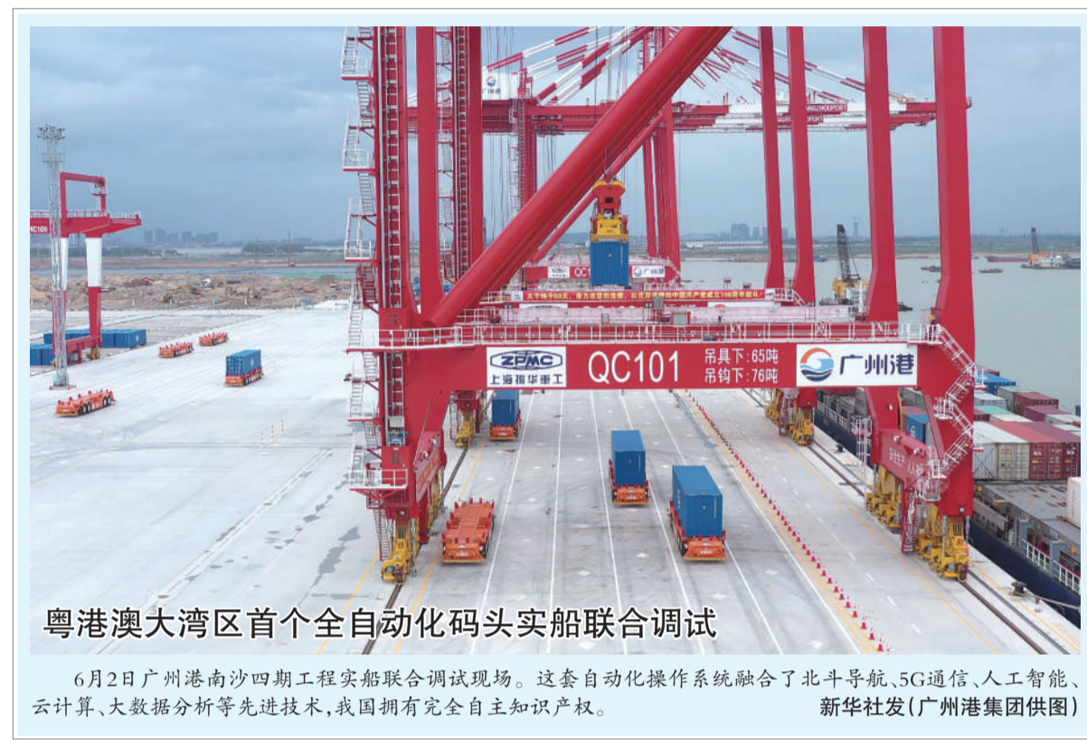
粤港澳大湾区首个全自动化码头实船联合调试 6月2日广州港南沙四期工程实船联合调试现场。这套自动化操作系统融合了北斗导航、5G通信、人工智能、云计算、大数据分析等先进技术,我国拥有完全自主知识产权。
