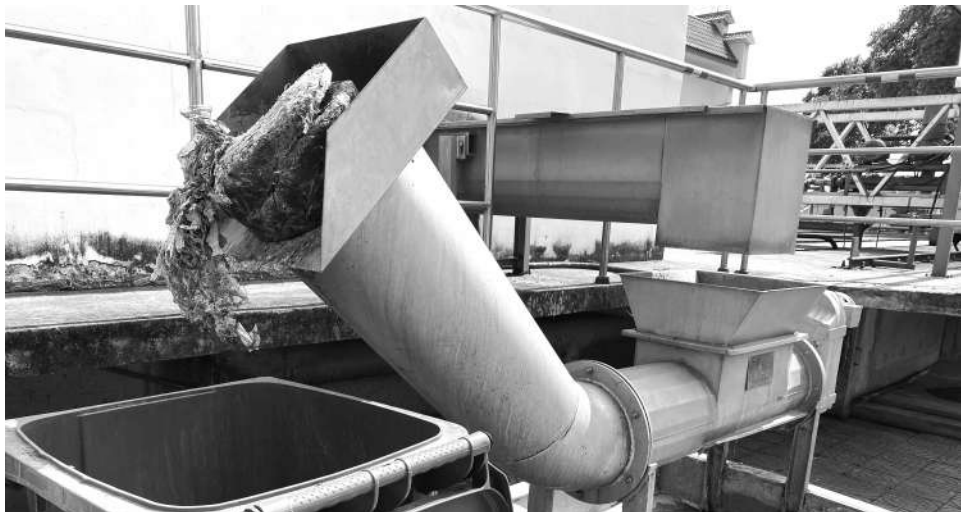
十五里河污水处理厂内细格栅拦截下水水中的悬浮物等各类垃圾 摄影/昌校宇
