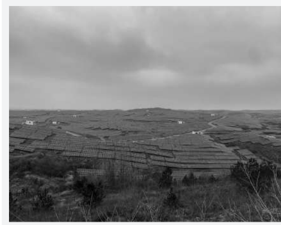
▲上图为京能国际湖北随州100兆瓦光伏电站项目 摄影/昌校宇
