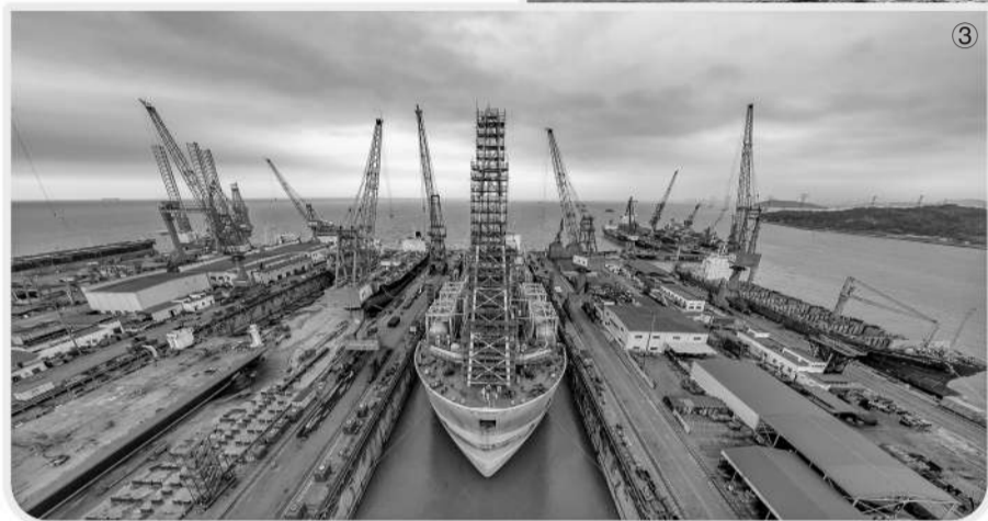
图1:正在建造中的中国海油恩平18-6平台上部组块(本报记者向炎涛摄)
