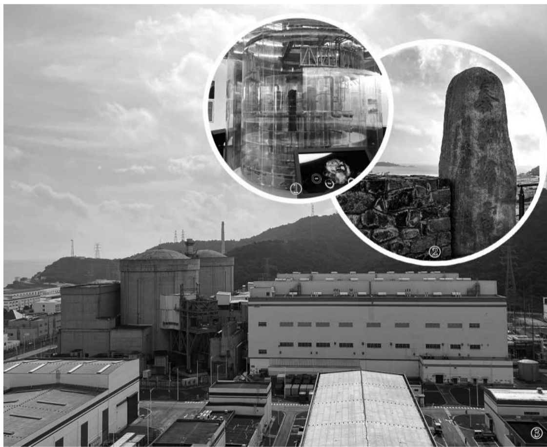
图①：“华龙一号”等比例模型 图②：秦山核电基地观景台 图③：秦山核电基地
