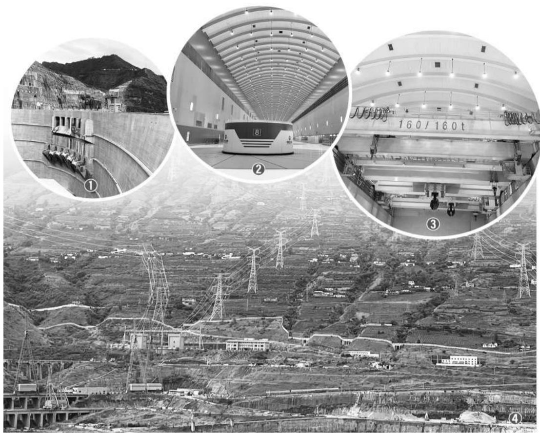
图①：白鹤滩水电站大坝
