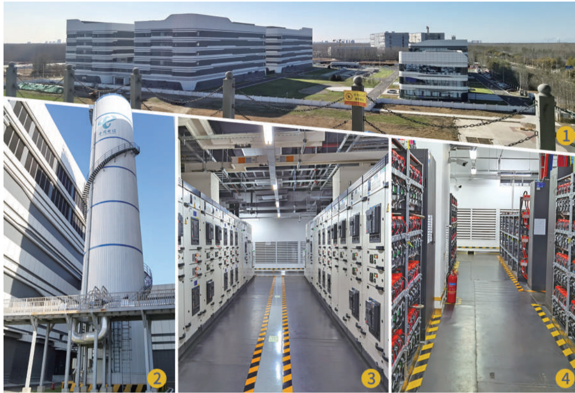
图①京津冀智算中心 图②蓄冷罐 图③电力室 图④UPS电源蓄电池
