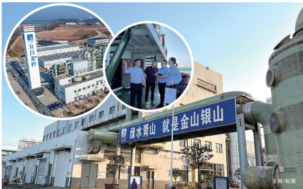
图①图③为宜昌北控投建的姚家港工业废物处理及资源化项目
