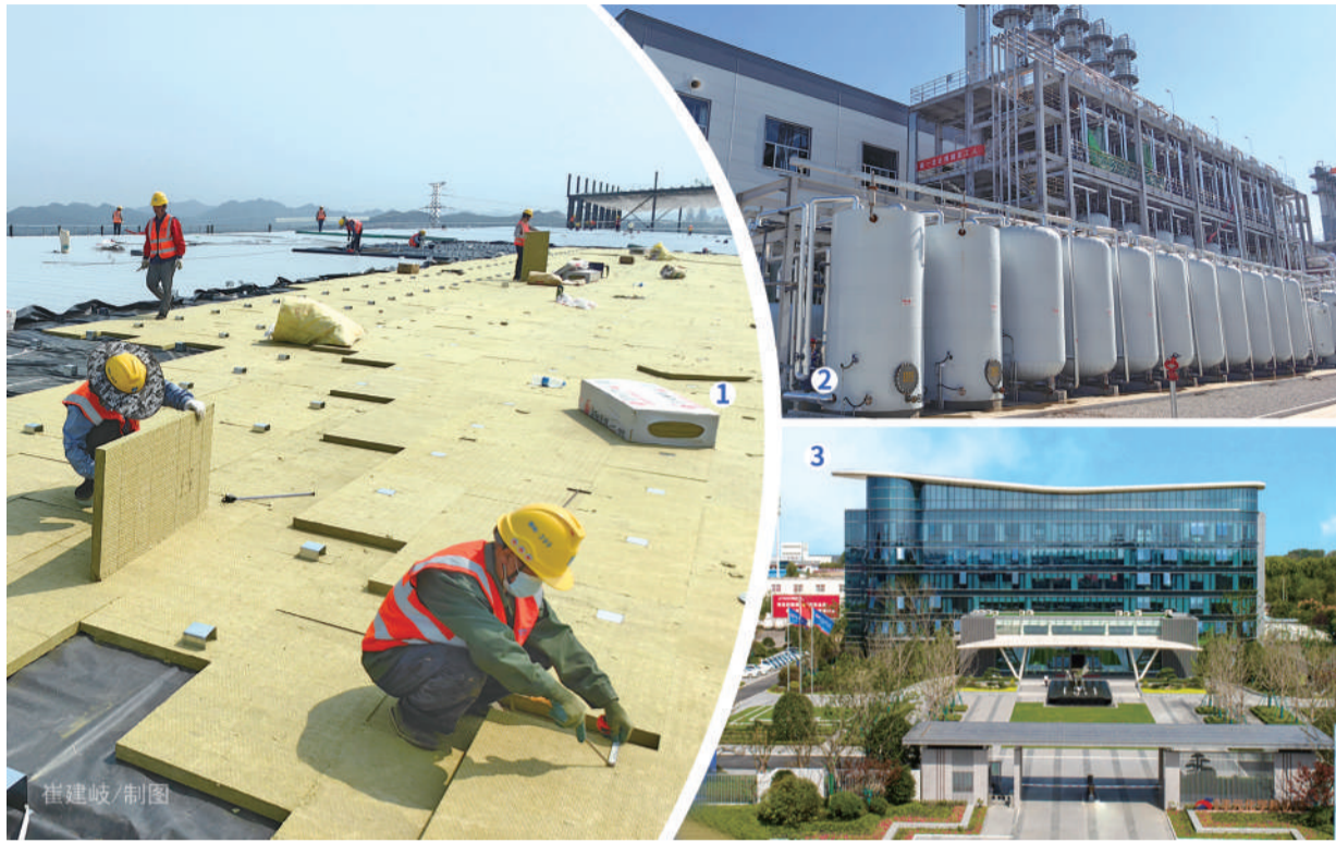
图①正在建设中的潍柴(烟台)新能源动力电池产业园 图②孚日股份子公司孚日新能源的电池级VC生产装置 图③丰元股份总部外景图
