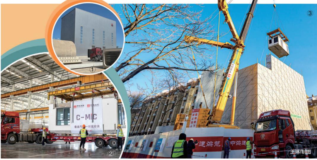
图①榆树庄园项目的装配式移动工厂 刘琪摄 图②中建海龙8项目的混凝土模块正在对外运输 杜雨萌摄 图③8项目的施工吊装现场 中建海龙供图
