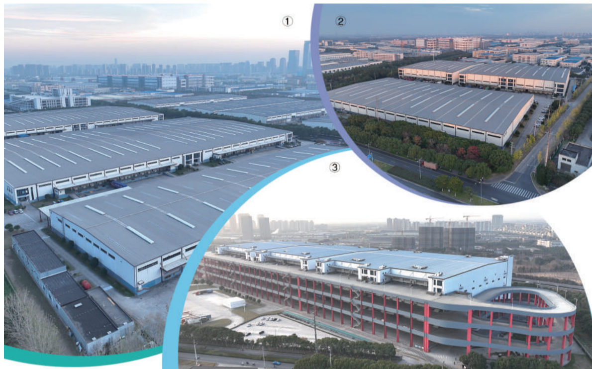
图① 富莱德昆山物流园一期项目 图③ 富莱德昆山物流园三期项目
