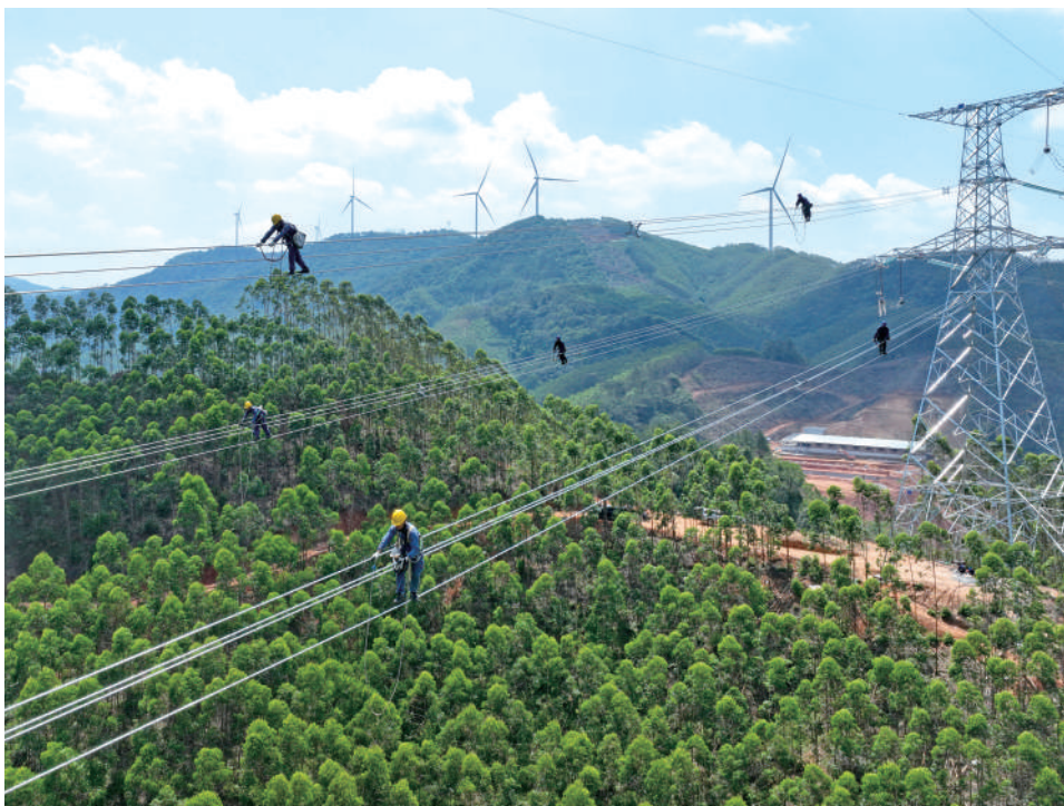
作为广西首座抽水蓄能电站电能输送的“大动脉”，南宁抽水蓄能电站500千伏送出线路工程由南方电网广西电网公司投资建设。图为5月13日，该工程现场，工作人员正在对输电线路进行走线验收工作。(马华斌 摄)
