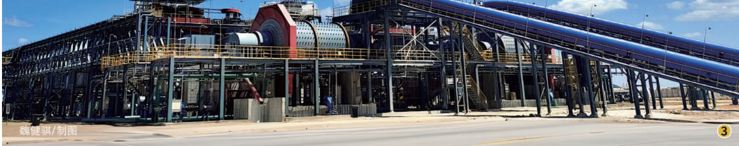
图③雅化集团津巴布韦卡玛蒂维锂矿采选项目
