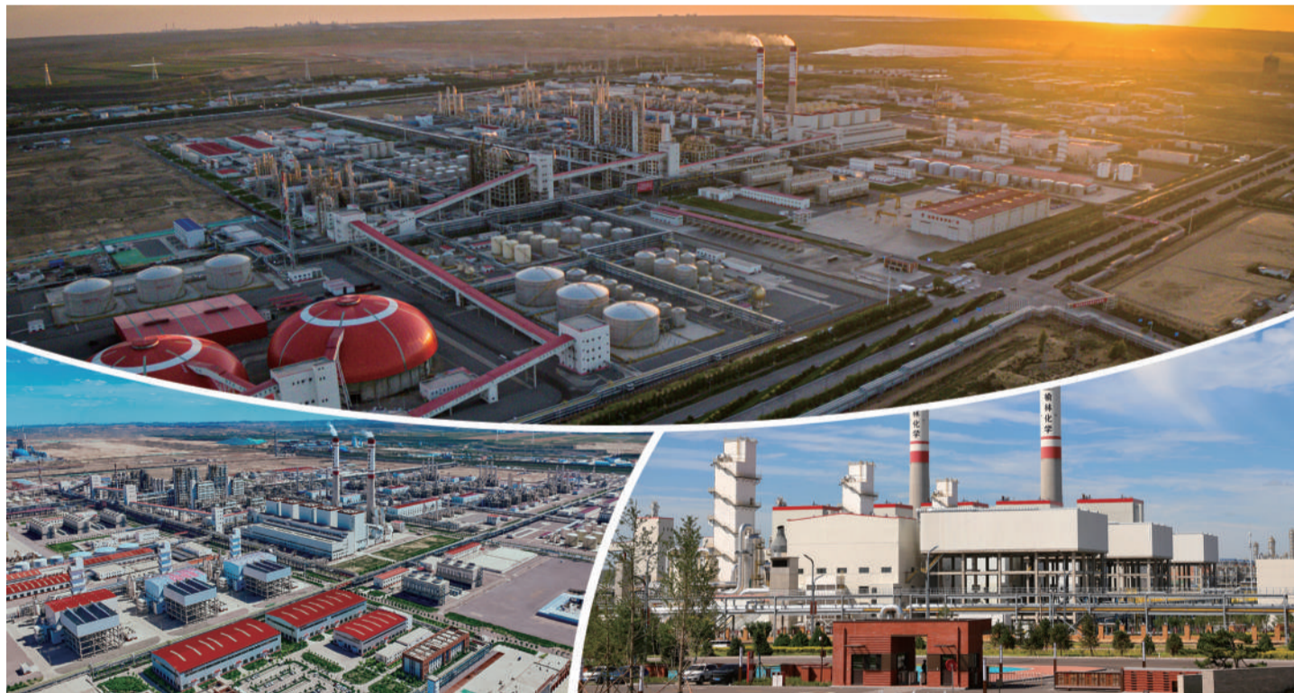
陕煤集团榆林化学有限责任公司厂区
