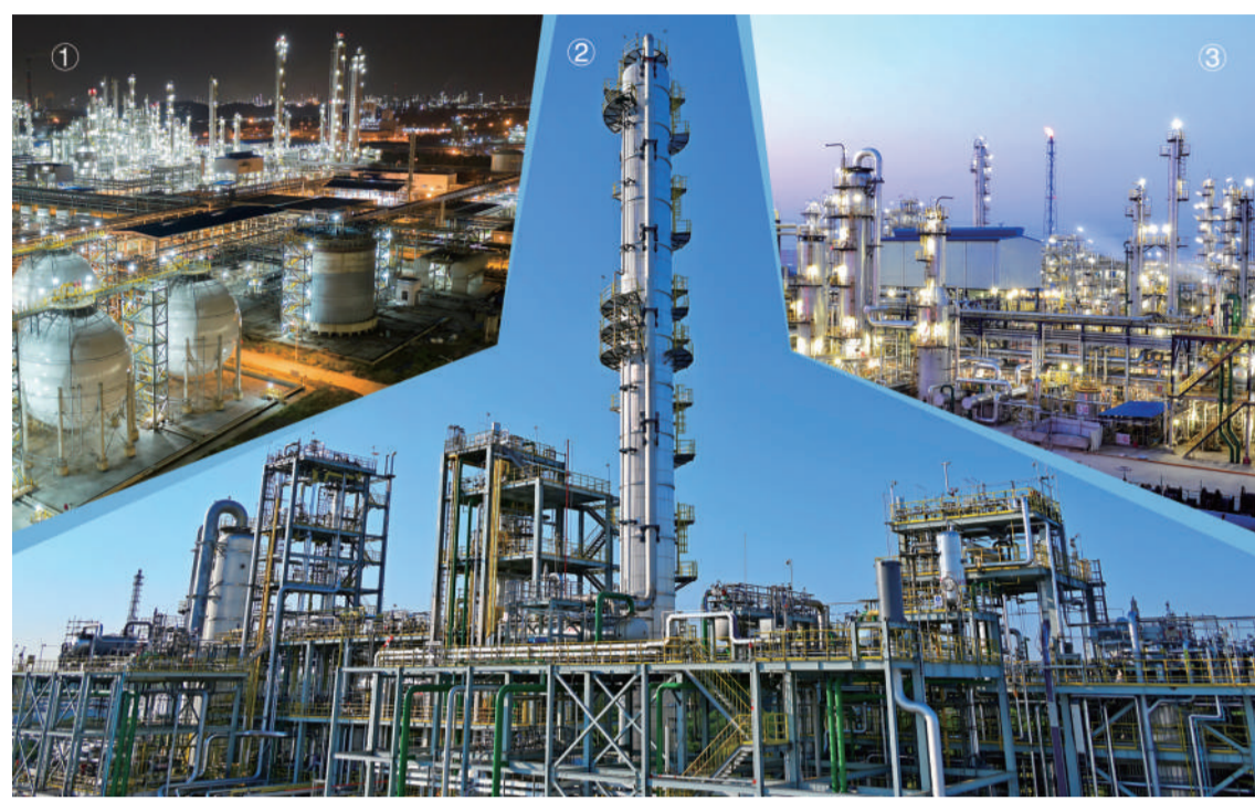
图①南京诚志厂区夜景 图②新材料一体化丙烯价值链项目装置 图③年产30万吨MTO装置 公司供图
