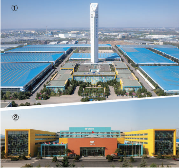
图①远大智能厂区 图②远大中国展厅外景
