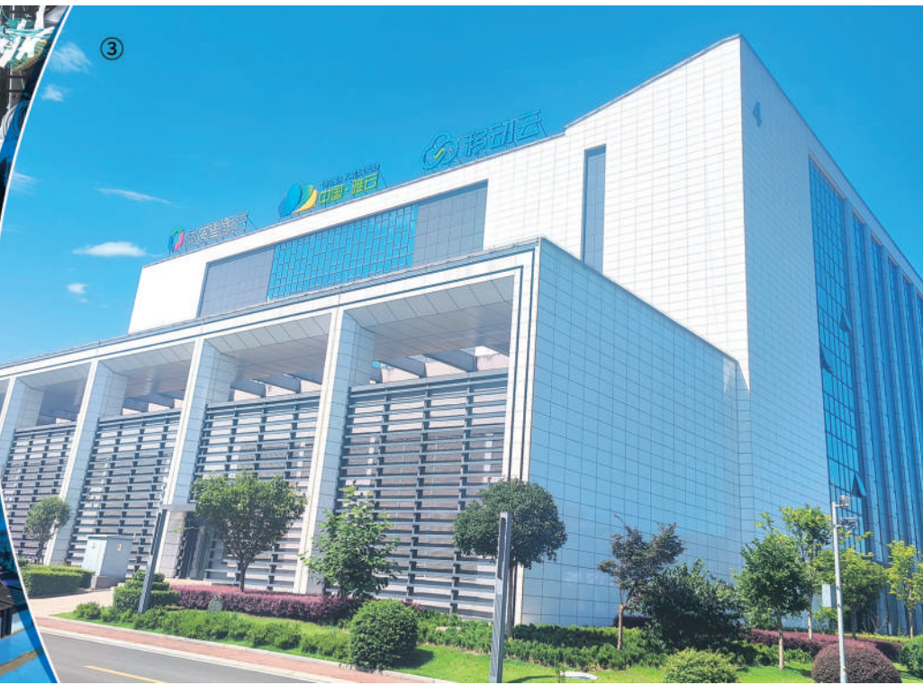
图③雅安大数据产业园内的中国移动数据机房
