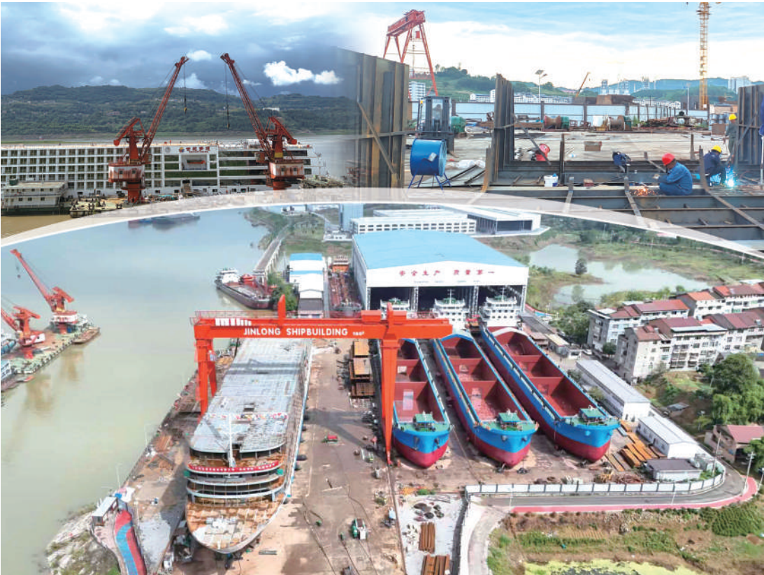
金龙船业厂区及码头车间多艘船舶正同步建造
