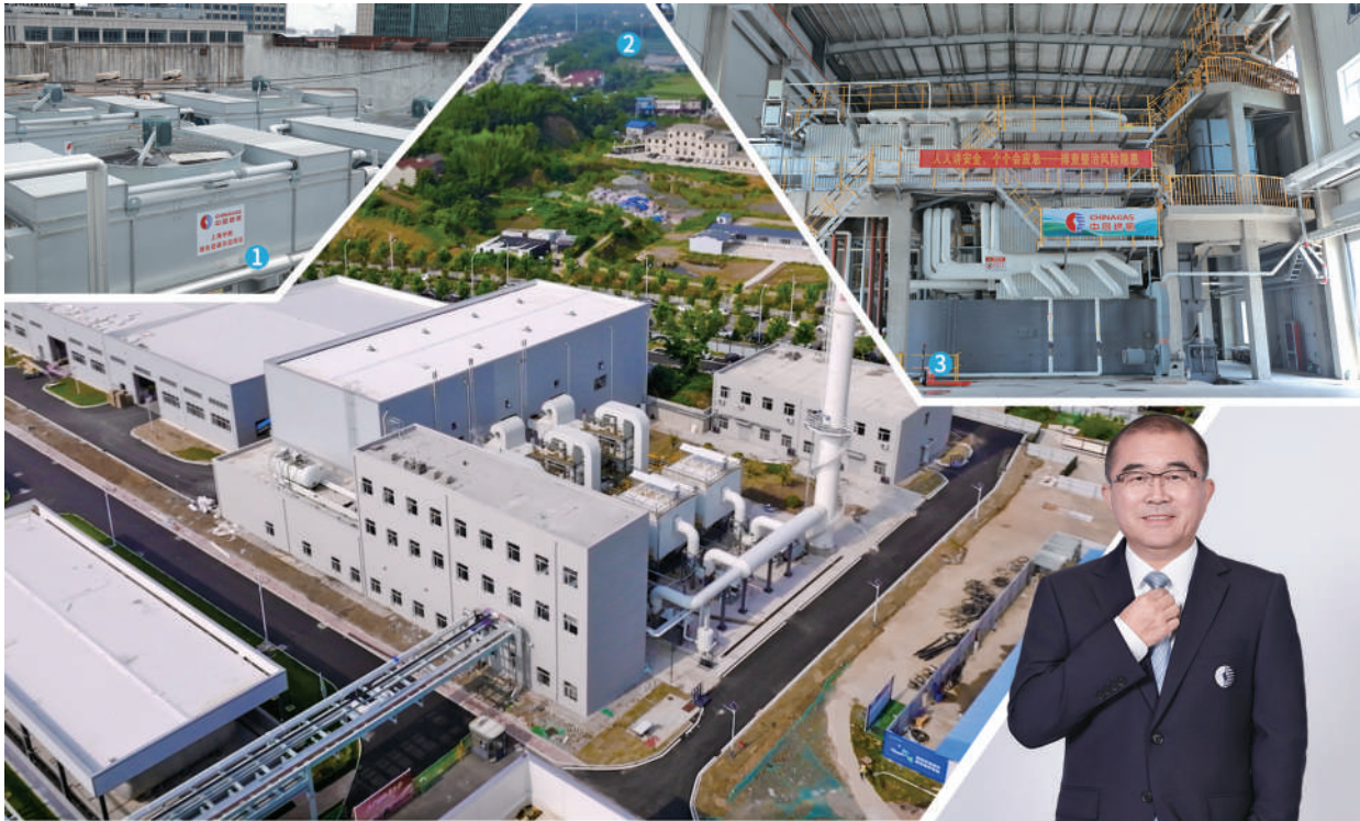
图①中国燃气上海东方大厦闭式能源塔热泵项目 图③公司打造的生物质绿色蒸汽项目内景 图②生物质绿色蒸汽项目 图④中国燃气董事会主席、总裁刘明辉
